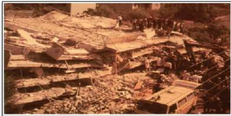
Figure I. 2: Effondrement total des constructions non ou mal contreventées [2].
