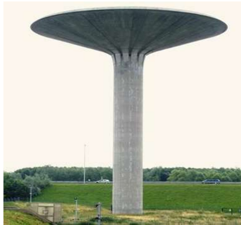
Figure I. 3 Aéroport Charles-de-Gaulle Château d'eau
