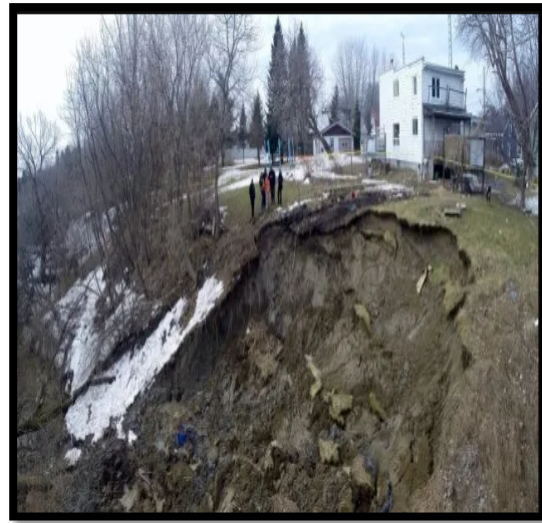
Fig.II.7 : Glissement de terrain à Saint Jude Juin 2014.
