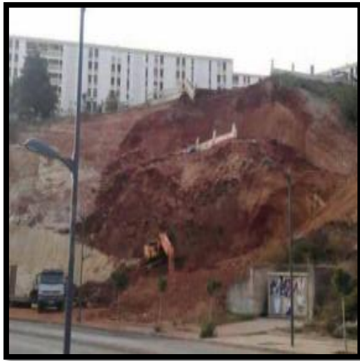
Fig.II.6 : Glissement de terrain à el Mouradia janvier 2019.
