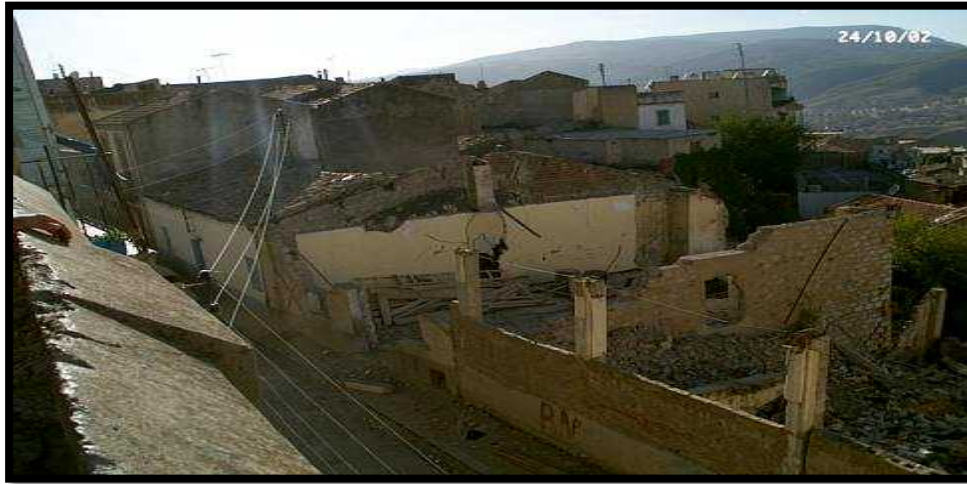
Fig.III.10 : Glissement de terrain quartier Boudraa Constantine [10].
