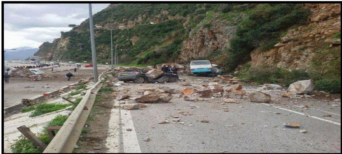
Fig.II.10 : Chute de pierres à Aokas, Bejaïa 2015.
