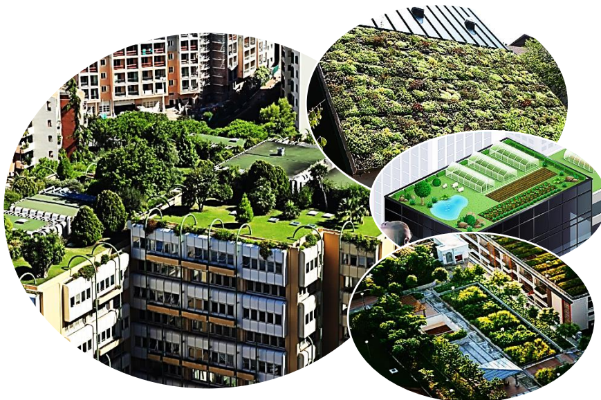
Figure I. 5 Bâtiments avec toiture végétalisée
