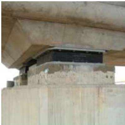
Figure III. 6 Appareil d'appui en élastomère fretté.
