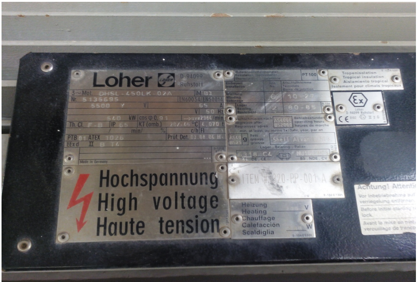
Figure 1.10: La plaque signalétique d'un moteur asynchrone.
