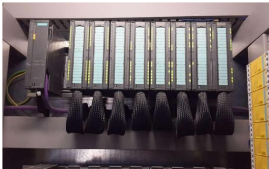
Figure 2.25: Modules Entrées/sorties d'un automate S7-300. [9]
