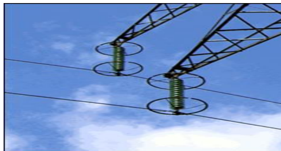
Fig. 1.5 : Image d'anneaux anti-effluve [11].
