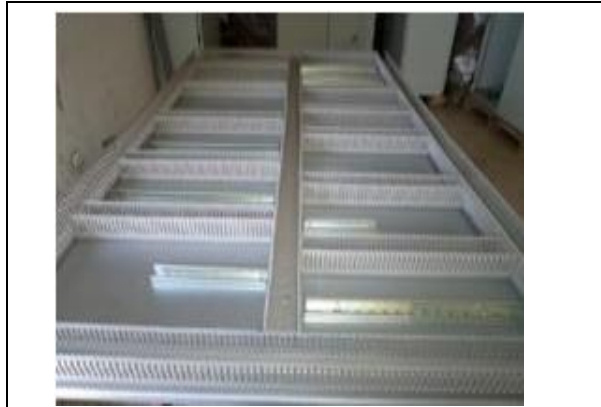
Fig. III. 27 : Installations des goulottes.
