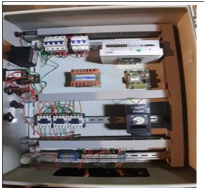
Fig. III.28 : La mise en place des appareils.
