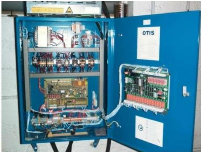
Figure (I.15) : Commande d'ascenseur par un microprocesseur [13].
