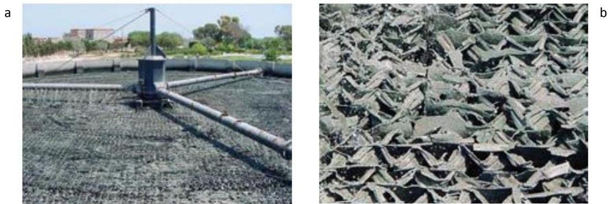
Figure 2 : (a) lit bactérien, (b) éléments de remplissage du lit bactérien
