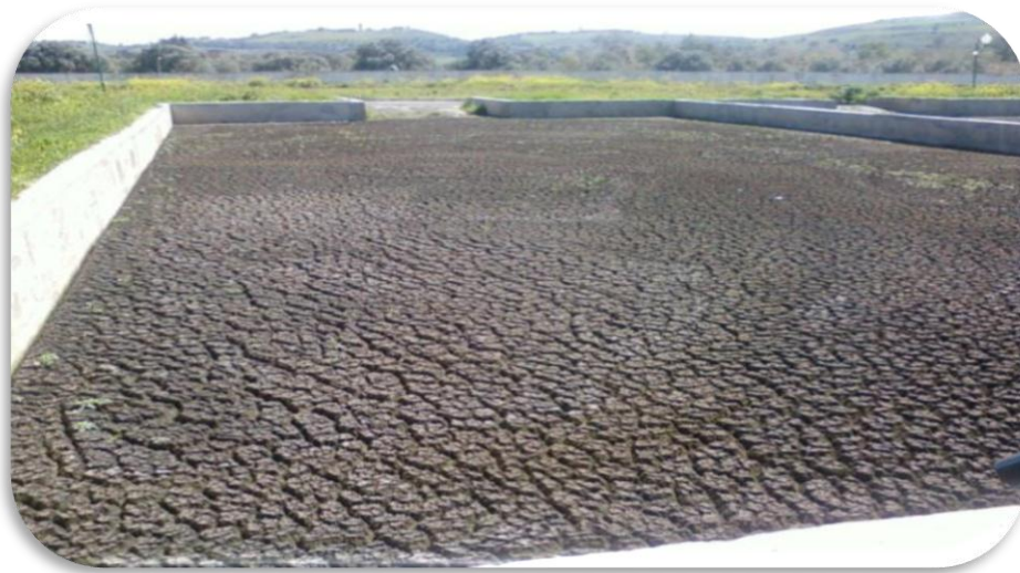
Figure 21 : Déshydratation des boues en lits de séchage
