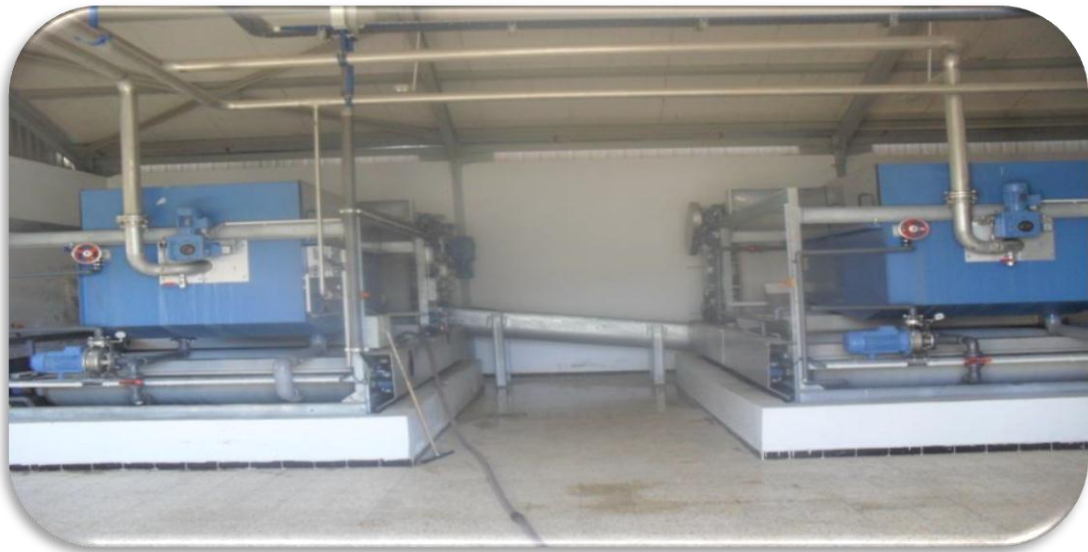
Figure 22 : Déshydratation mécanique des boues
