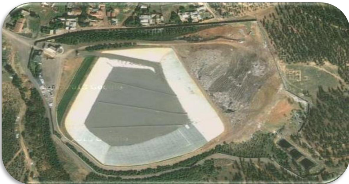
Figure 23 : CET de Bouira photo de Google Earth
