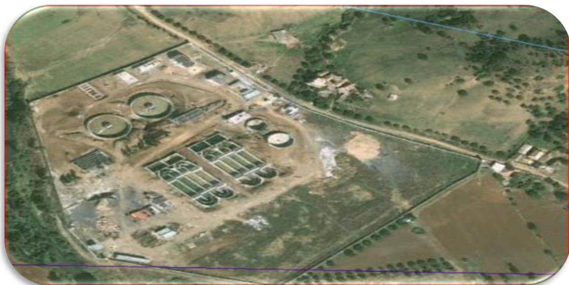
Figure 6 : Image de la station par Google earth.
