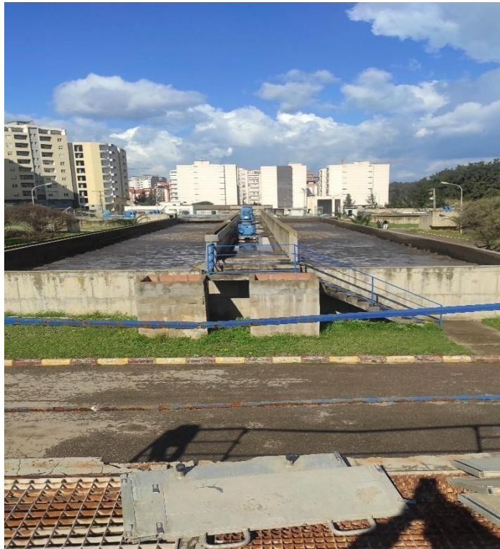
Figure I.10: Bassin d'aération
