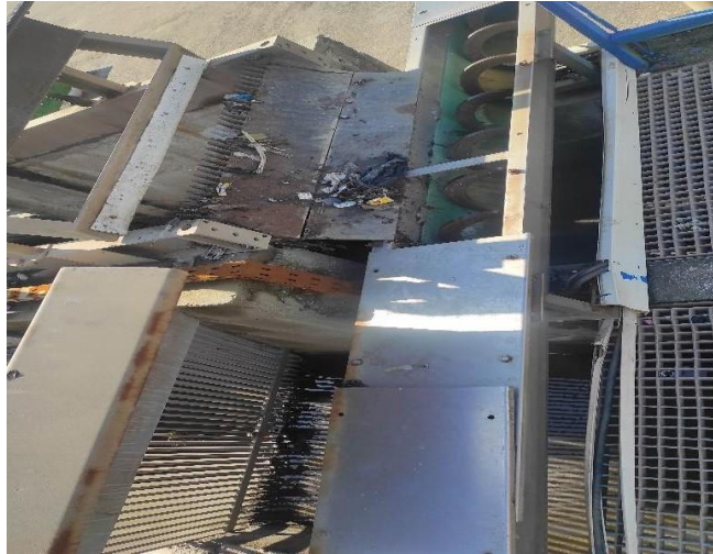
Figure I.8: Dégrilleur manuel
