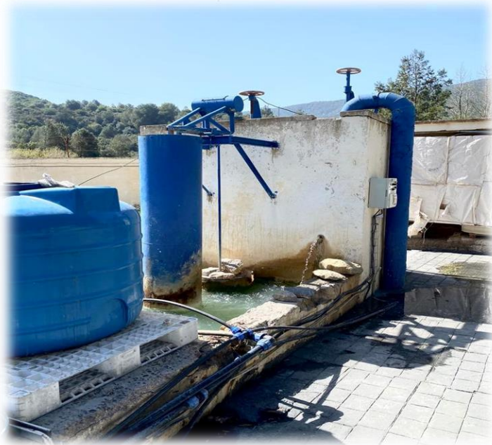
Figure II. 5:Chambre d'équilibre et la vanne cylindrique
