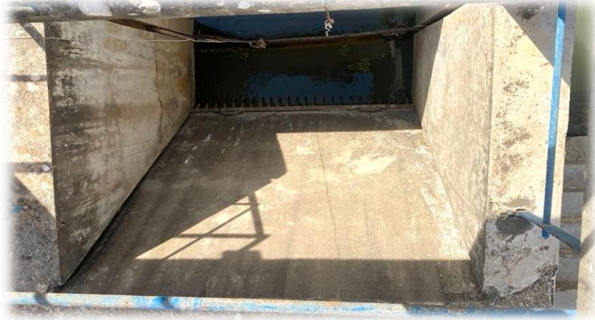
Figure II. 2: Dégrilleur moyenne de la station
