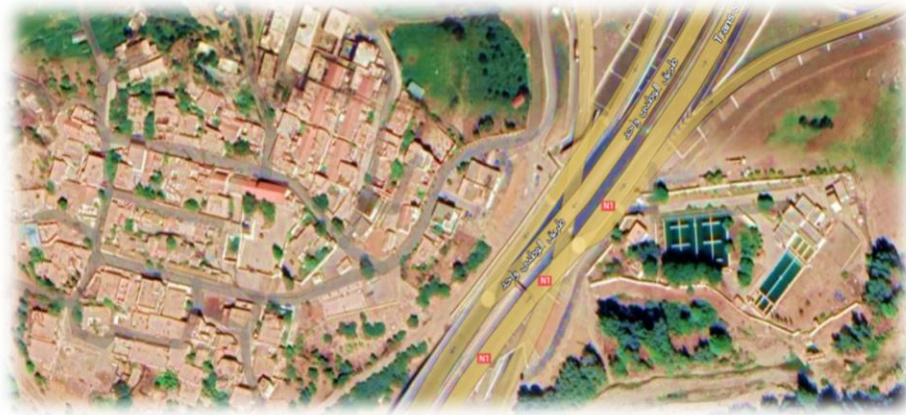
Figure I. 1 : Vue aérienne de la station de traitement des eaux potables Chiffa
