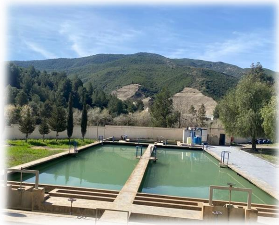
Figure II. 7: Les décanteurs
