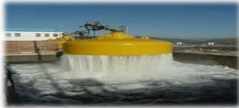
**Figure N°05:** Robinet à disques
