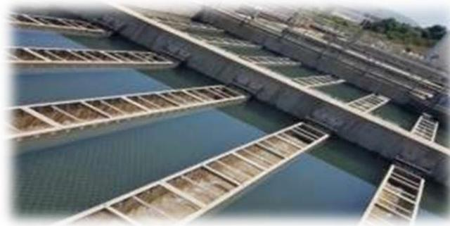
**Figure N°09:** Décanteur lamellaire.
