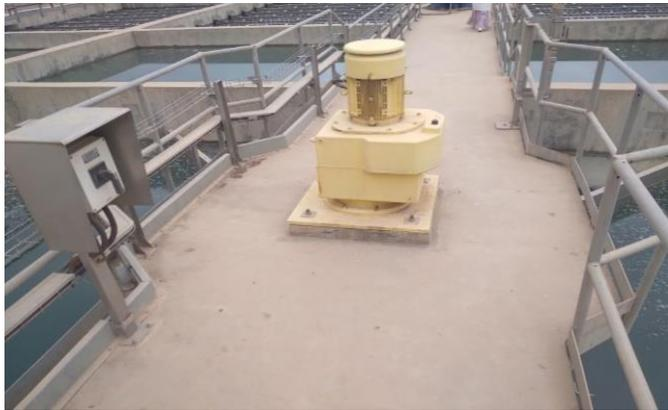
**Figure N°08:** Turbine (floculateur)
