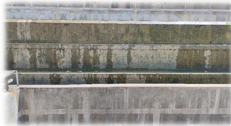
**Figure N°06 :** Cascade d'aération
