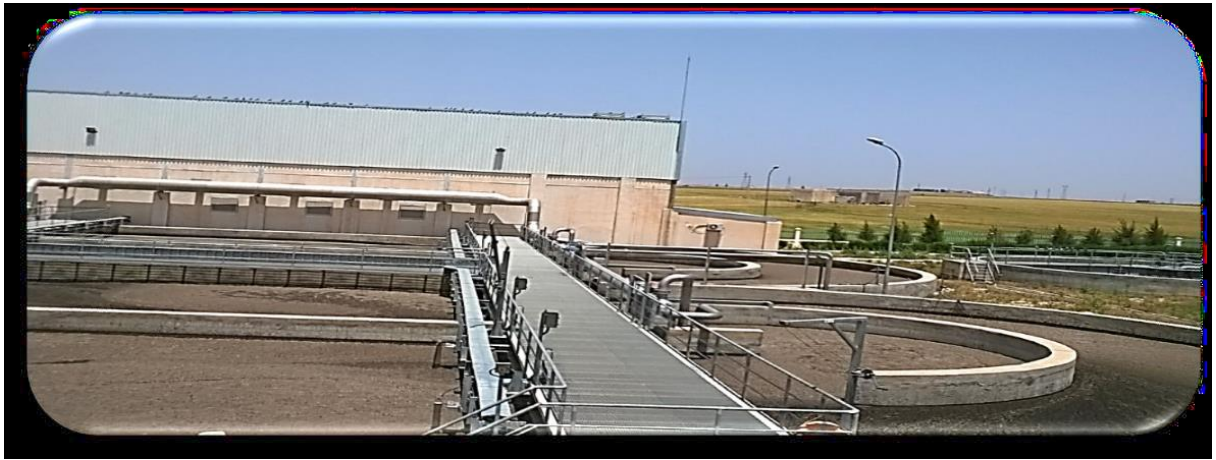
Figure 19 : Le digesteur des boues épaisses
