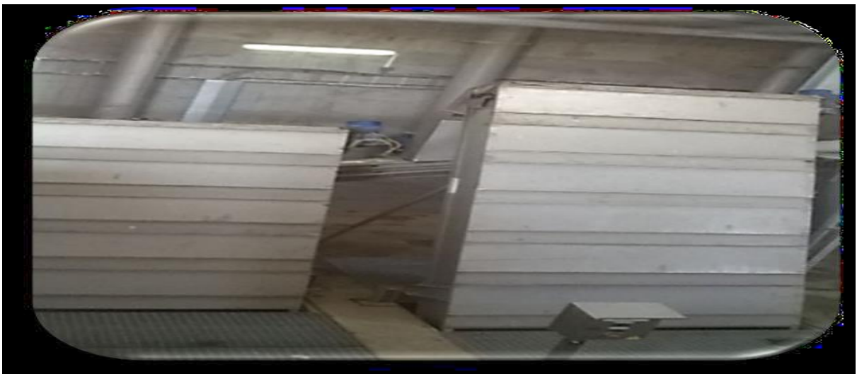
Figure 8 : Le Dégrillage grossier
