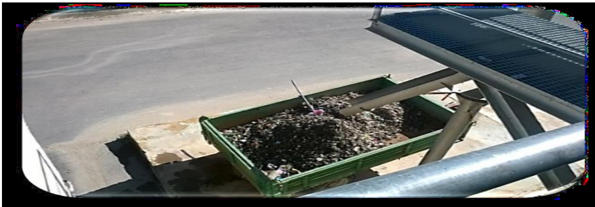
Figure 11: La benne de déchets de dégrillage fin.
