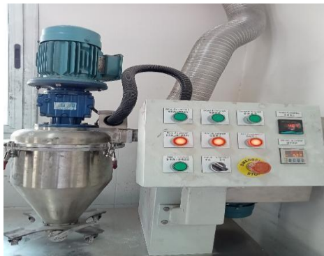
Figure I.3. La cuve de mélange.
