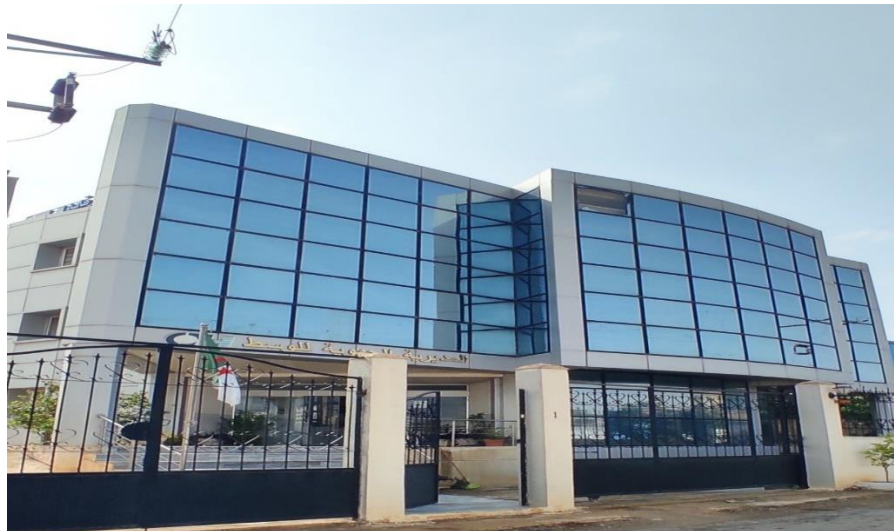
Figure I. 2: Contrôle technique centre-Blida (entrée principale)
