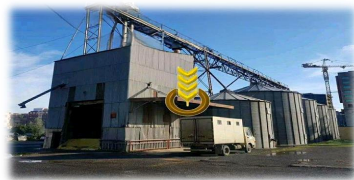
Figure 7 : Silo métallique (CCLS BOUIRA 2023).
