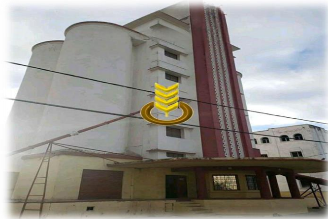
Figure 6 : Silo en béton armé (CCLS BOUIRA 2023).
