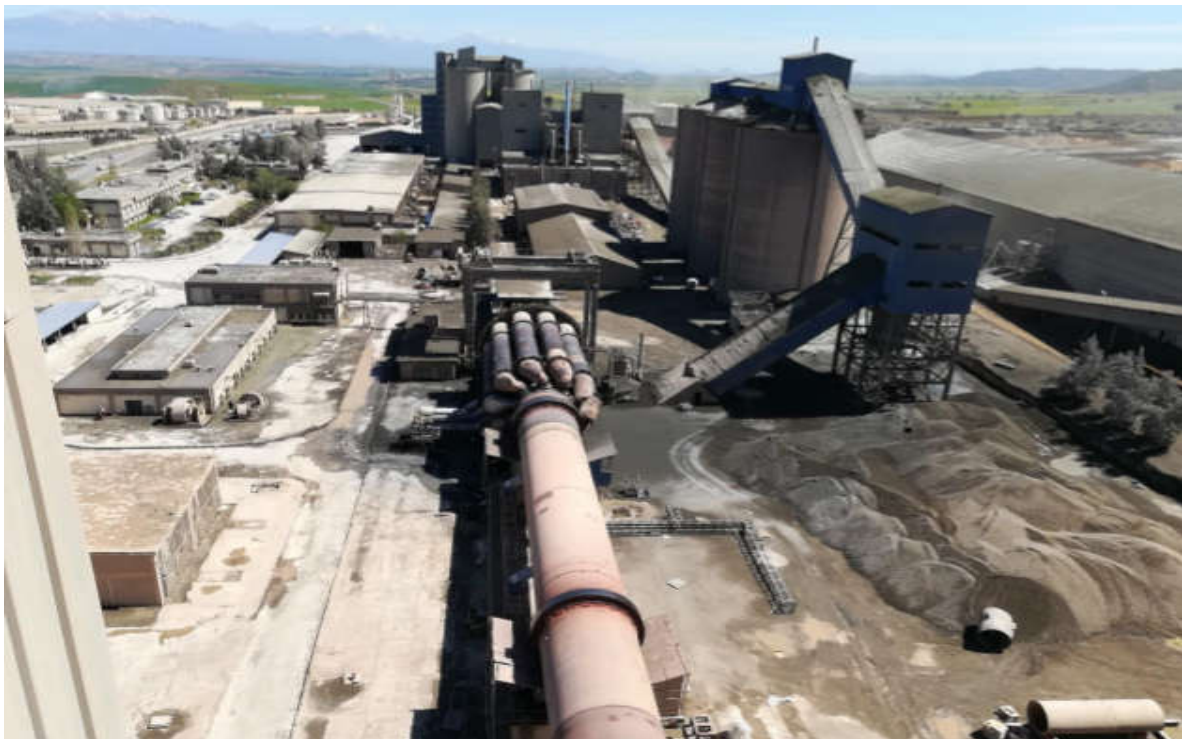
Photo 01 : Cimenterie de Sour El Ghozlane (Ayadi et Elhafaia, 2018).
