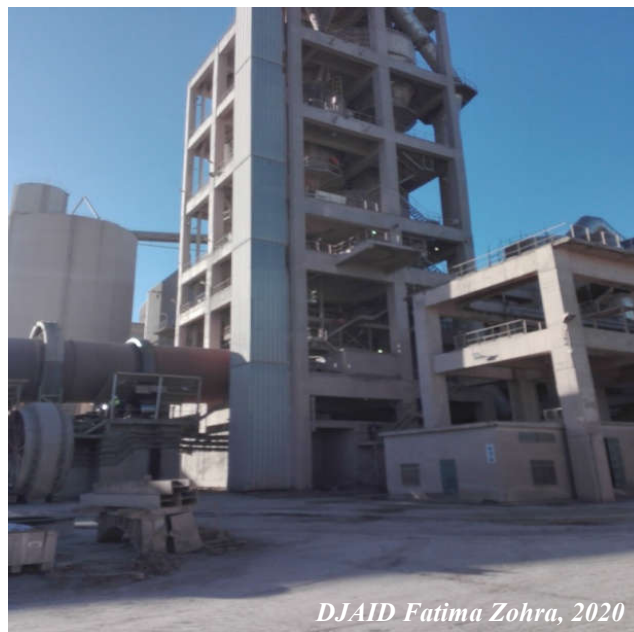
Photo 03 : Préchauffeur à cyclone.
