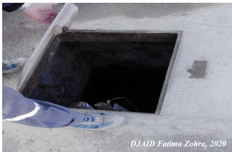
Photo 15: L'ouverture de puits de pompage.
