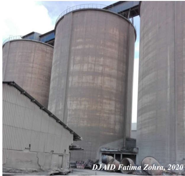
Photo 04: Silo de stockage de clinker.
