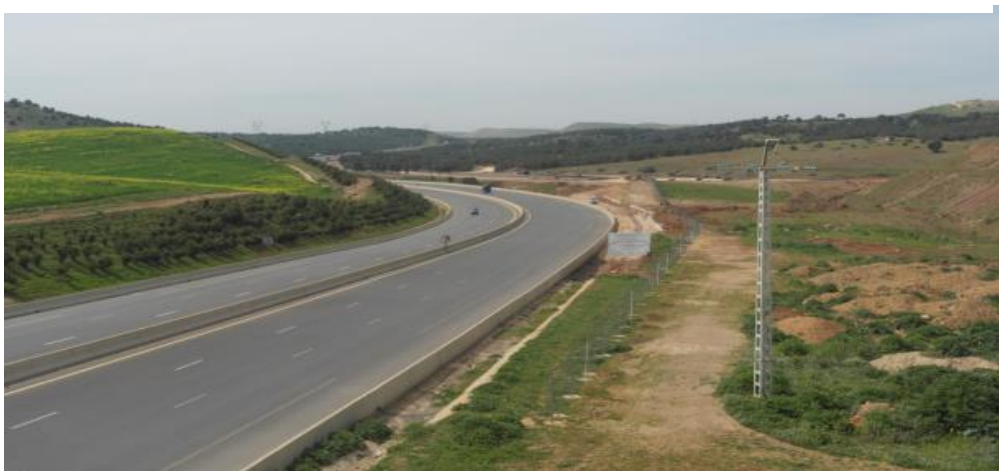
Figure II.6 : Partie du Pont de la voie Pole sud (17.04.2023)
