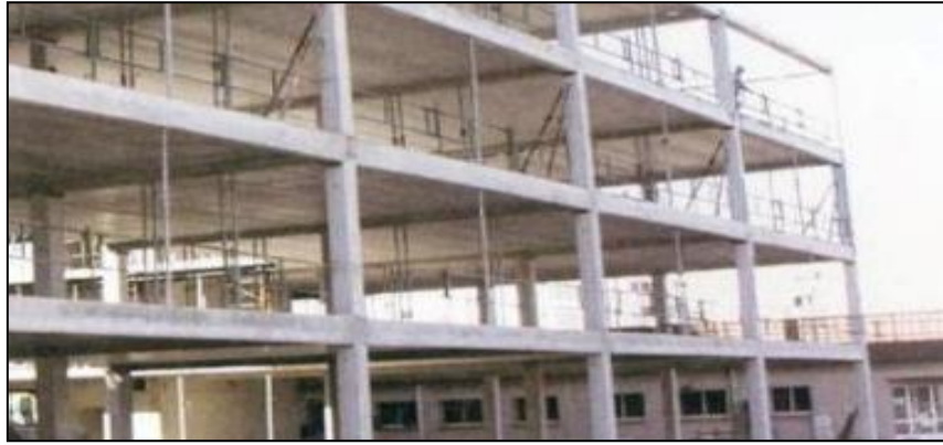
Figure I. 5 : Structure contreventé par portiques [2]
