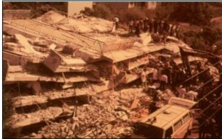
Figure I. 2: Effondrement total de la structure. (Séisme de Kalamata Grèce 1987) [2]
