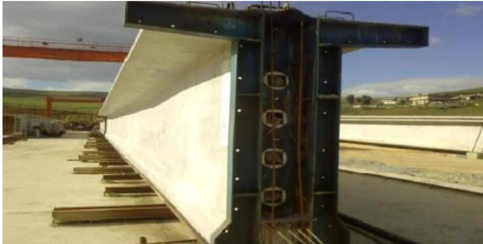
Figure 2.12: Le coulage du béton.
