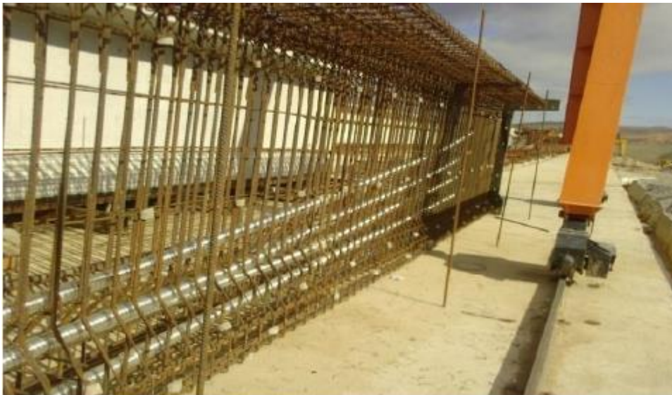
Figure 2.11: La mise en place des gaines dans le coffrage.
