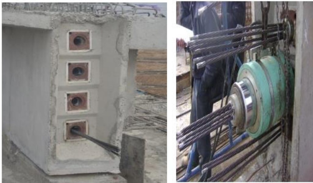
Figure 1.13: Introduction des câbles dans les gaines et leur mise en tension.
