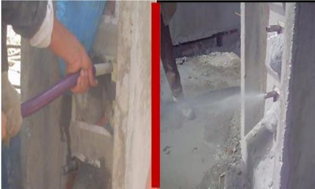
Figure 2.14: Remplissage des gaines.
