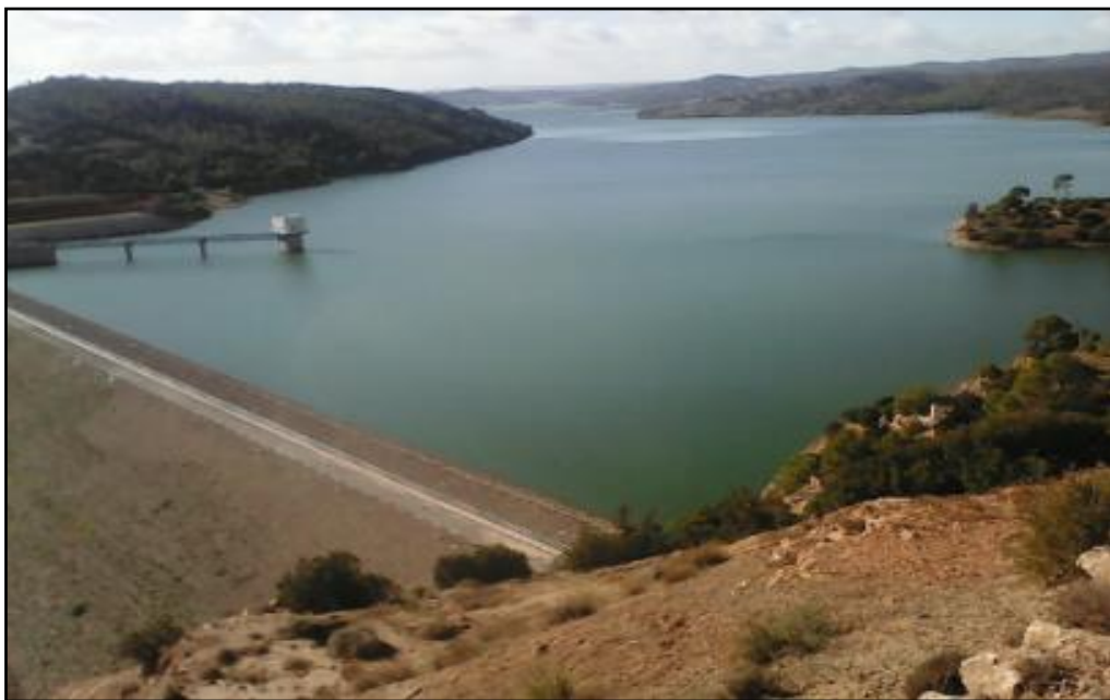
Figure I. 6 : Photo du barrage Tilesdit
