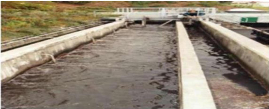
Figure I. 3 : photo d'un déssableur [19]
