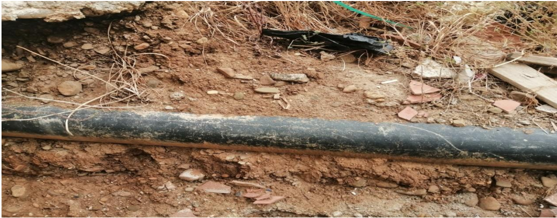
Figure III.11: Conduite de refoulement
