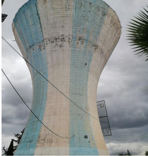
Figure VII.58: Châteaux d'eau (Draa el bordj, Bouira)
