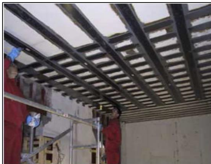
Figure II.11. Consolidation de dalle par fibre de carbone [37]
