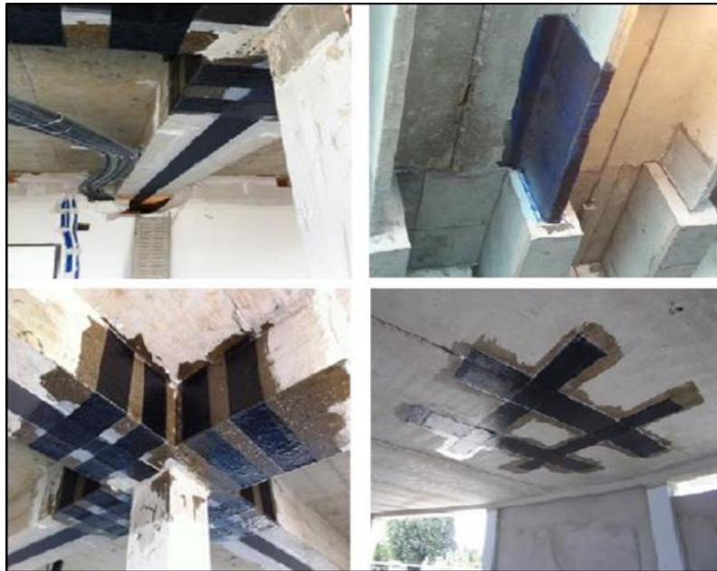
Figure II.15. Plusieurs usages de la technique de renforcement EBR [31]
