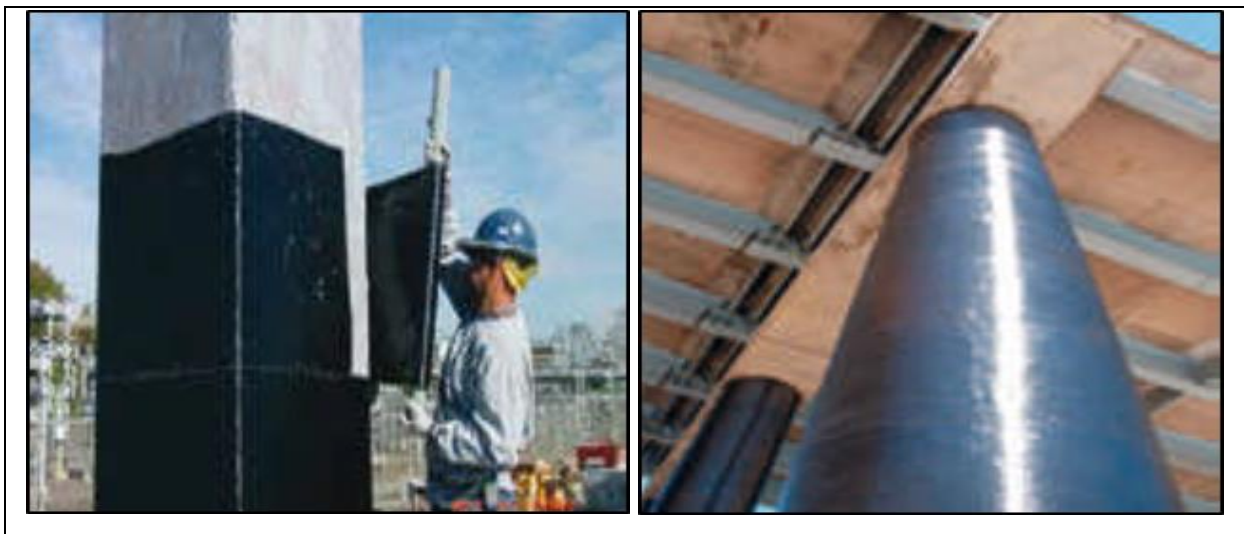
Figure II.9. Confinement (chemisage) de poteaux à l'aide de PRF [35]
