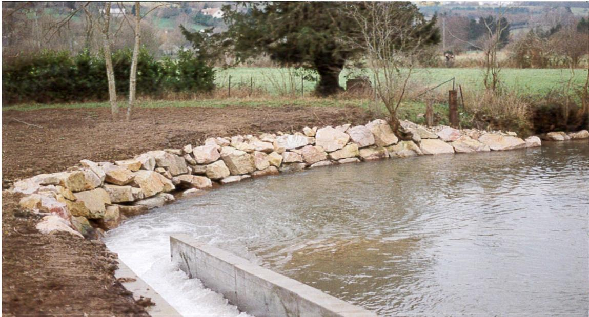
Figure I.18 : protection d'un barrage par enrochement
