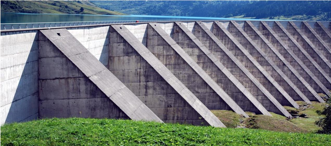
Figure I.4 : barrage a contrefort <sup>[4]</sup>.
