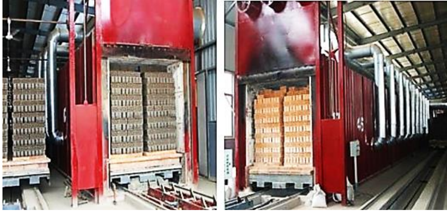
Figure I-19 : A gauche l'entrée des briques dans le four et à droite la sorte des briques après la cuisson.
