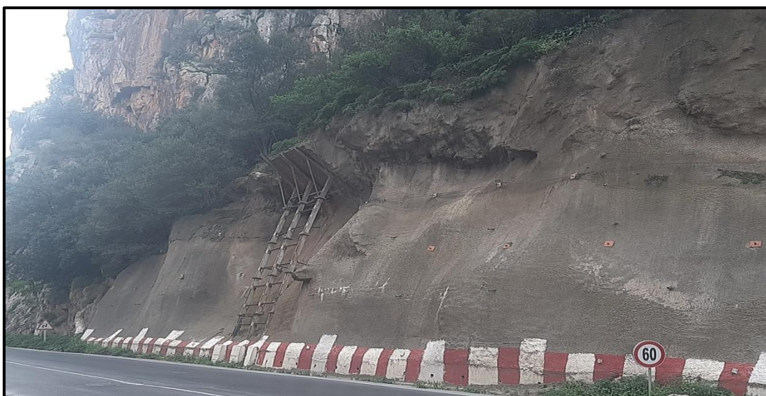
Figure I.18: Mur en sol cloué (La route nationale 05_Lakhdaria)
