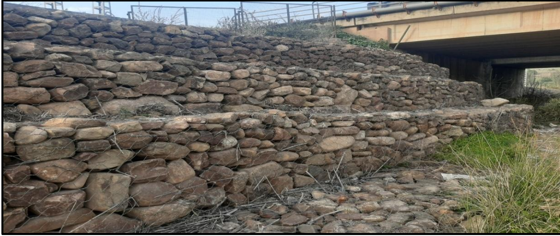
Figure I.2: mur en gabion (autoroute Est Ouest –village boulerbah )
