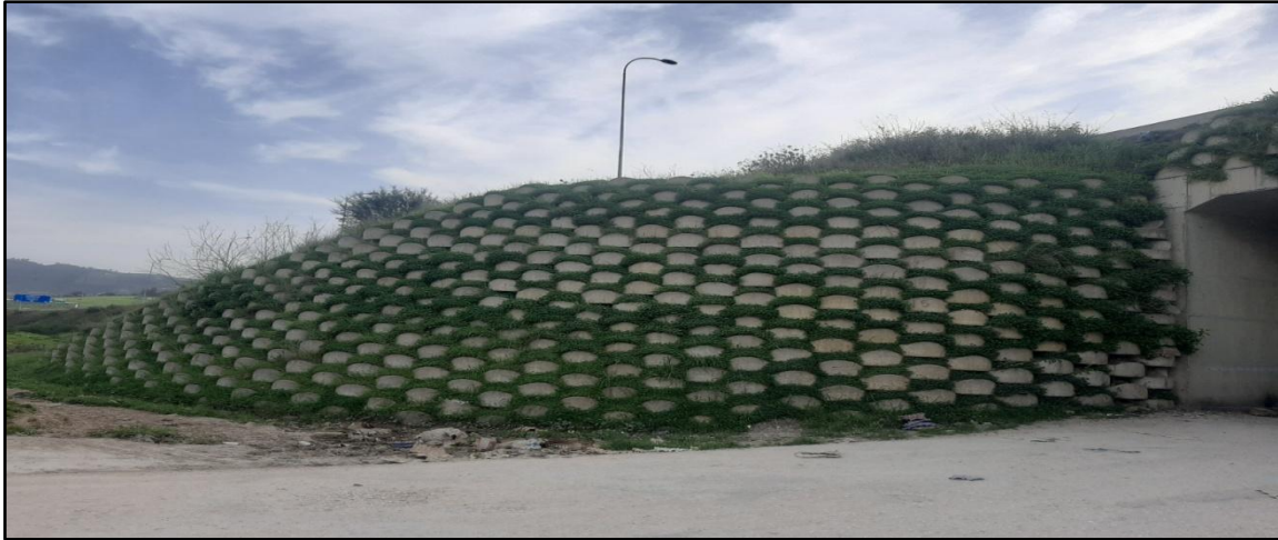
Figure I.5: mur caisson (autoroute Est Ouest.Lakhdaria).
