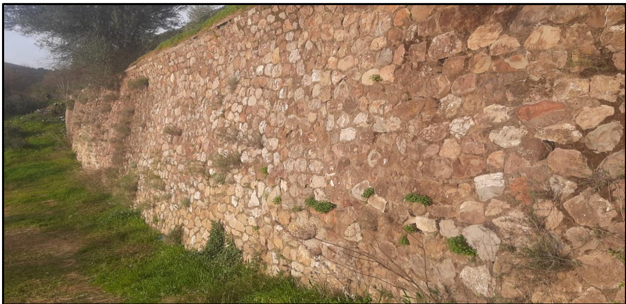
Figure I.3: Mur poids en maçonnerie jointoyée (La route nationale 05_Lakhdaria)
