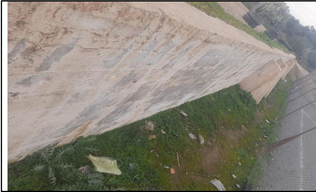
Figure I.1: Mur poids en béton non armé( village djebahia).
