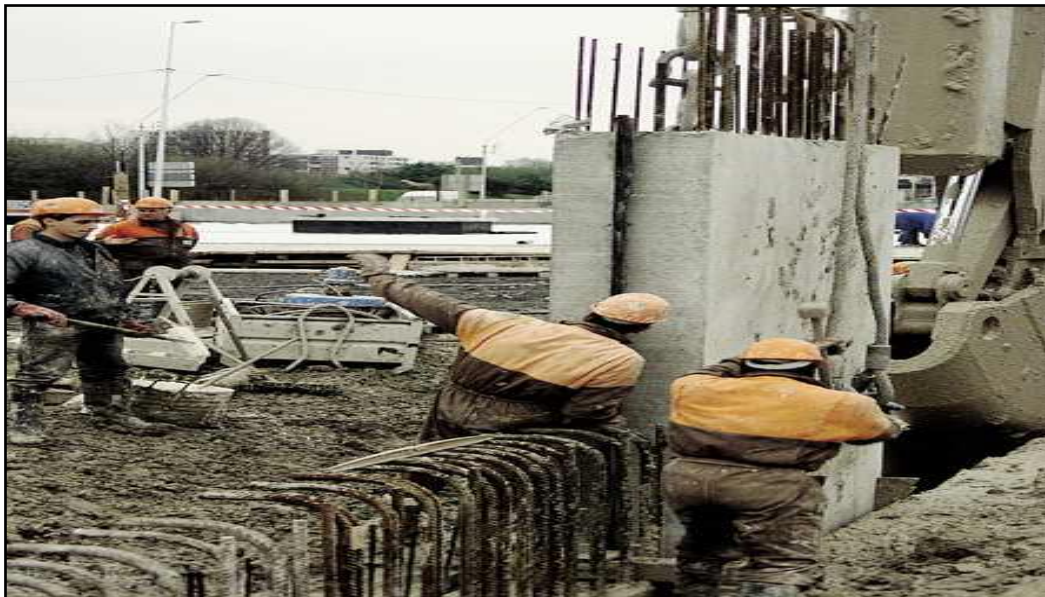
Figure I.14: mur de soutènement en parois préfabriqué.
