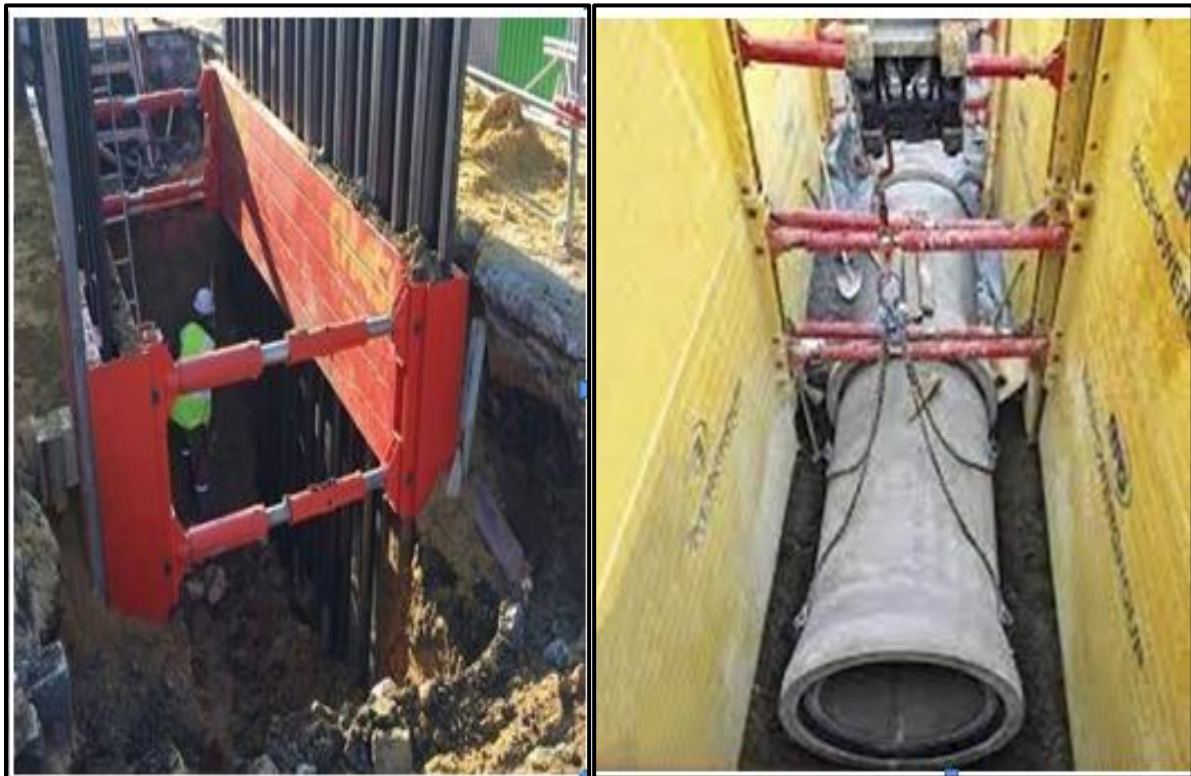
Figure I. 25: Blindage des fouilles.
