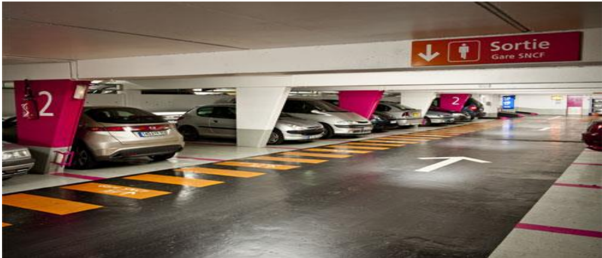
Figure I.5 : Parking fermés ou souterrains [5]
