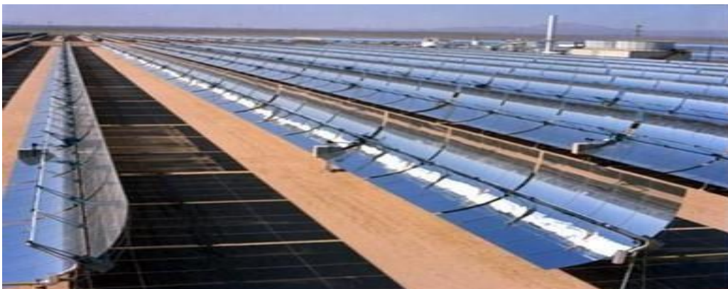
Figure III .8: Ensemble d'une centrale à capteurs cylindro-paraboliques [16]
