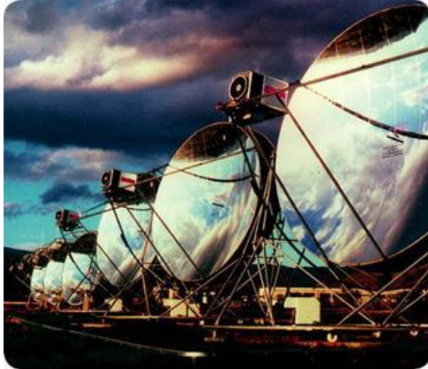
Figure III.4 : Centrales à capteurs paraboliques [29]
