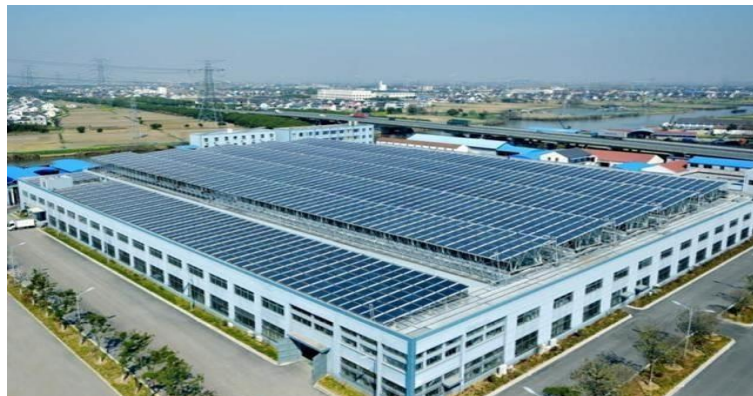
Figure I.9 : Centrale solaire Jiangsu Yitong [17].
