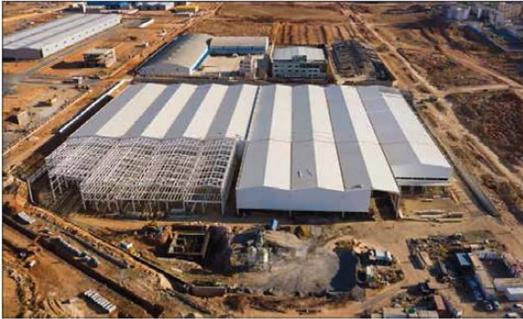
Figure III.3 : Travaux sur l'unité de production Pharmaceutique BIOPHARM OEB [64].
