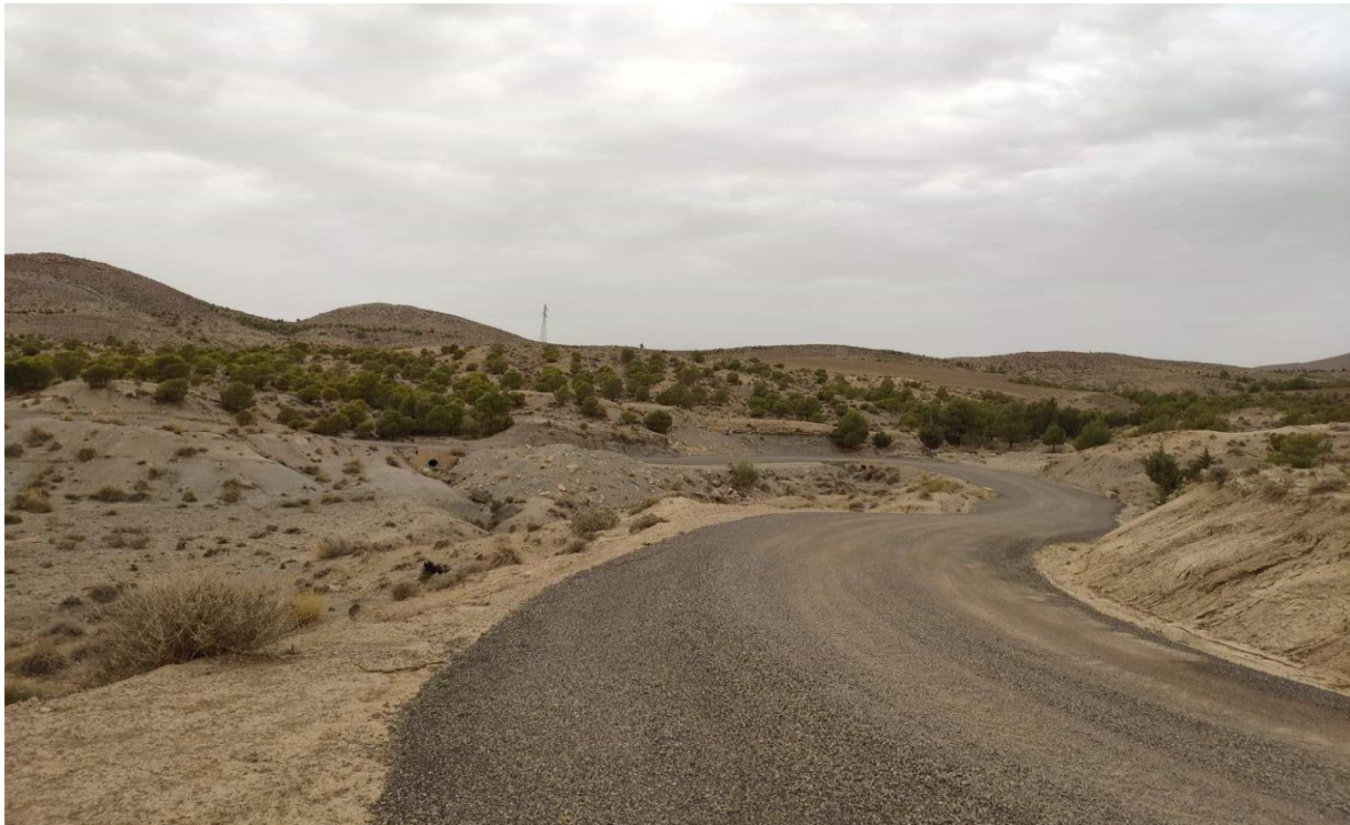
Figure 25: Aménagement de piste forestière sur 08Km en 2020.
