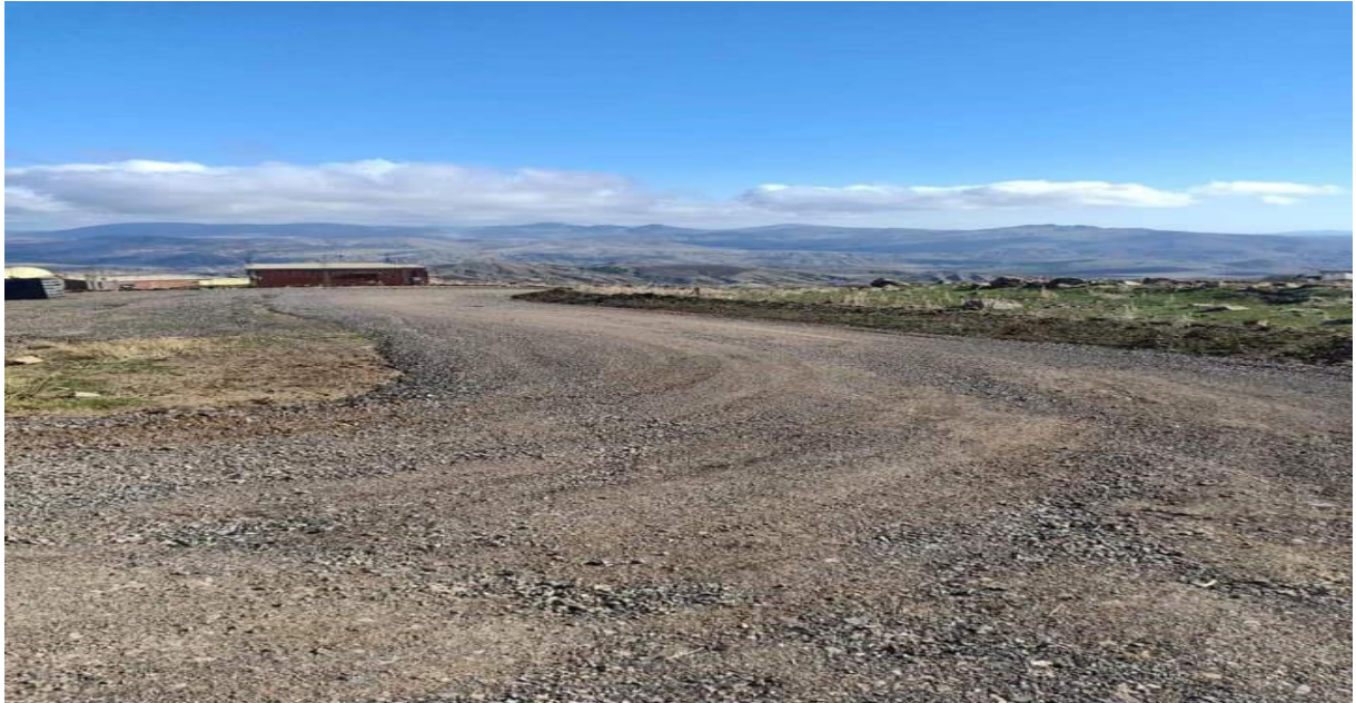
Figure 26: Aménagement de piste rurale sur 2,9 Km en 2020.
