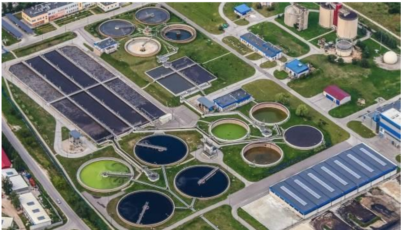
Figure I.1: image aérienne d'une station d'épuration des eaux .
