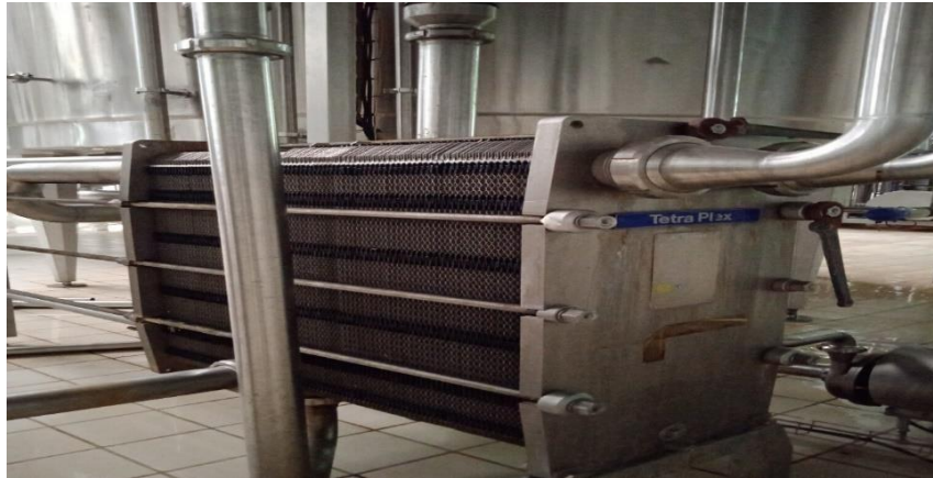
Figure I.5: Échangeur de chaleur à plaque
