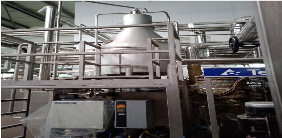
Figure I.2: Désaérateur (Dégazeur)
