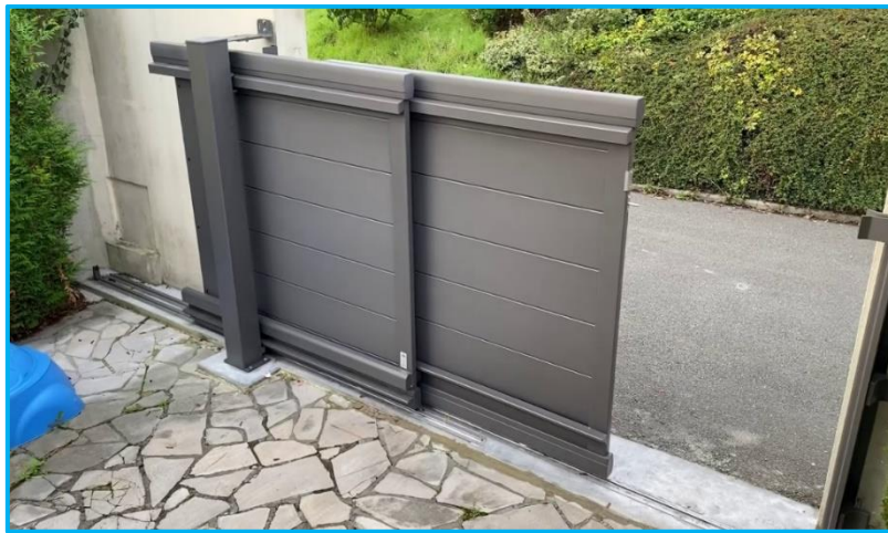
Figure 1.8 : Portail coulissant avec motorisation à rail au sol [19].
