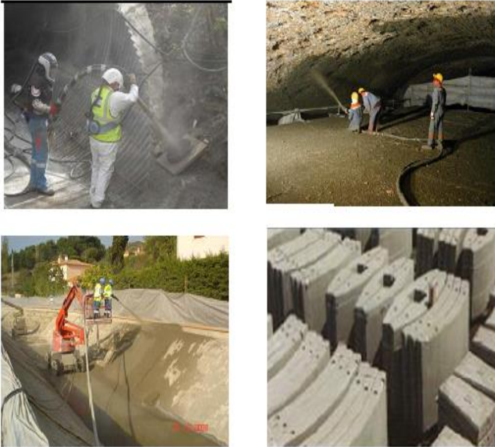
Figure I.7. Quelques exemples d'application des bétons de fibres : a)-Renforcement des buses métalliques d'assainissement par chemisage à l'aide de la projection de BFM, b)- Renforcement des caniveaux des eaux de ruissellement par la projection de BFM , c)- Mise en œuvre de la coque de la structure de tunnels par projection du BFM (projeté)
