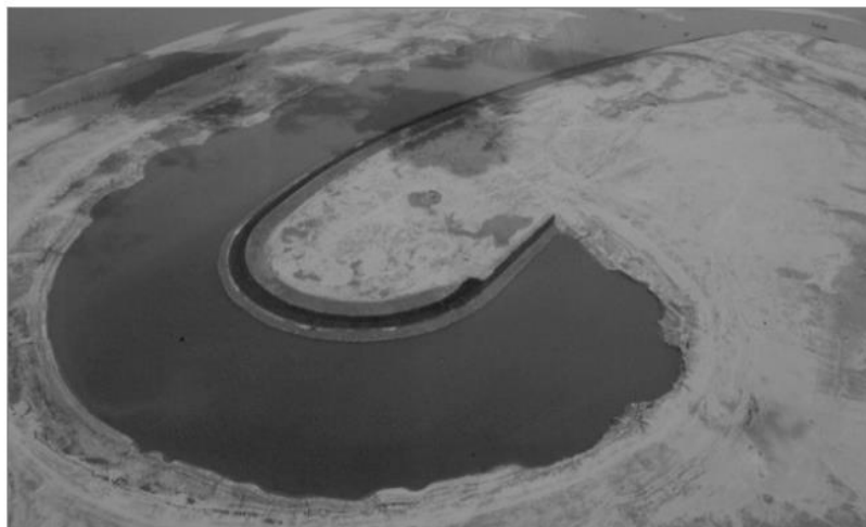
Digue longitudinale de grande envergure construit avant
