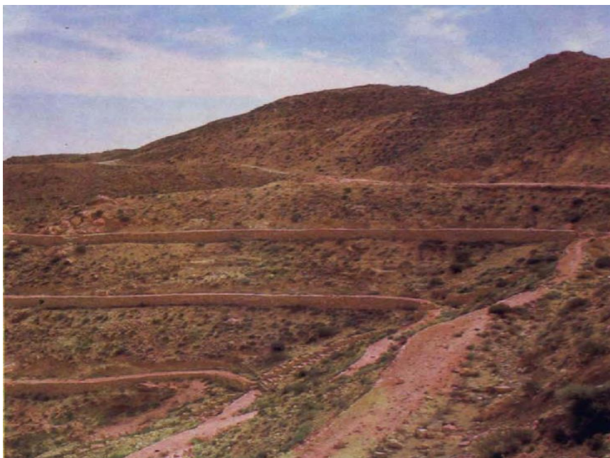
Murs en pierres locales pour la diversion et l'épandage de l'écoulement
