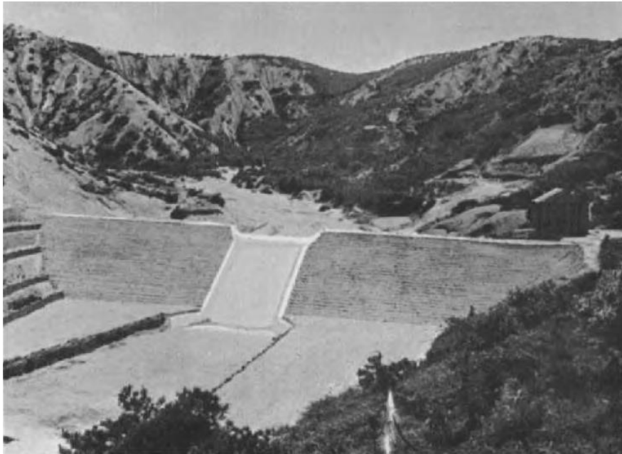
Dispositif mécanique (barrage) pour stopper et ralentir les flux liquides érosifs
