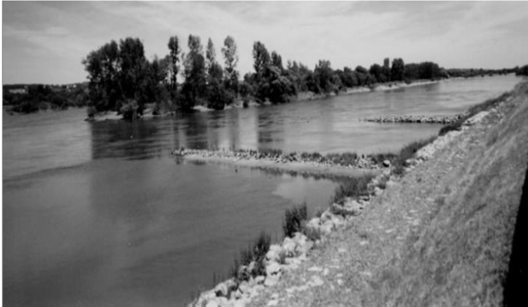
Système d'épis sur la Loire (source : Service Maritime et de Navigation de Nantes)
