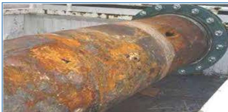
**Figure 15:** Corrosion générale (rouille) d'une pièce en acier (**Ropital, 2009**).
