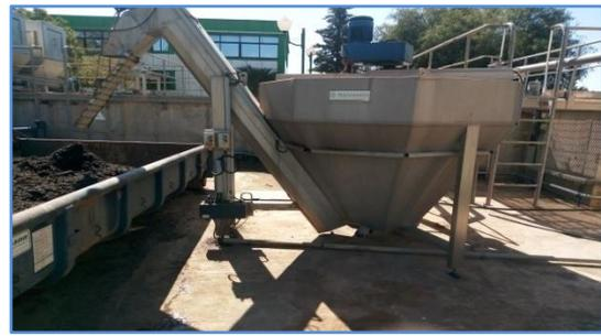
**Figure II.10** Dessablage/déshuilage (source : auteur). **Figure II.11** Laveuse de sable.
