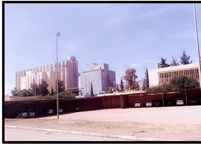
Figure N 07 : Photo de moulin Agrodif Ksar.El.Boukhari.(photo originale)
