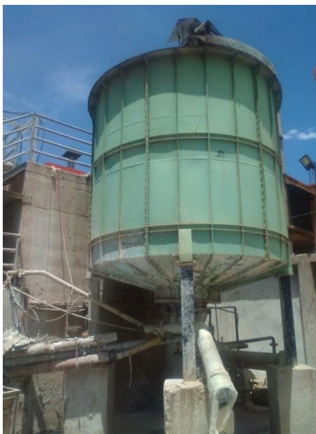
A) Microflotateur DAF
