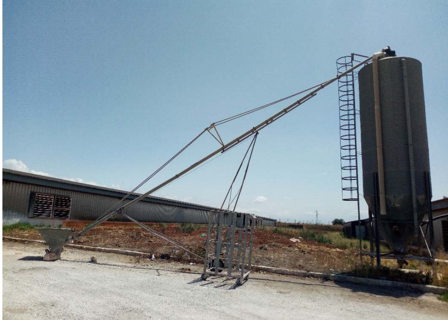
Figure 23 : Silo (Photo personnelle, 2021).
