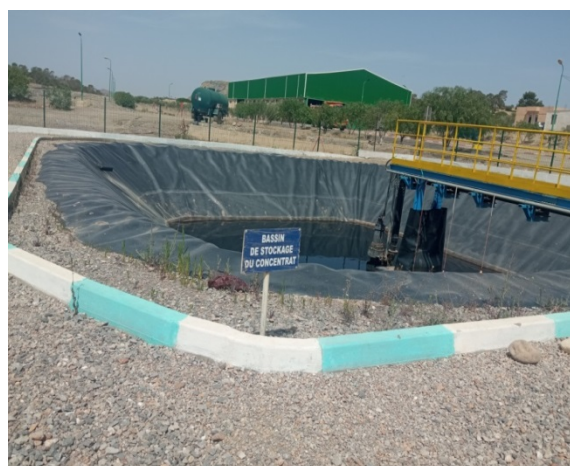
Figure 38 : Bassin de stockage de concentrât.
