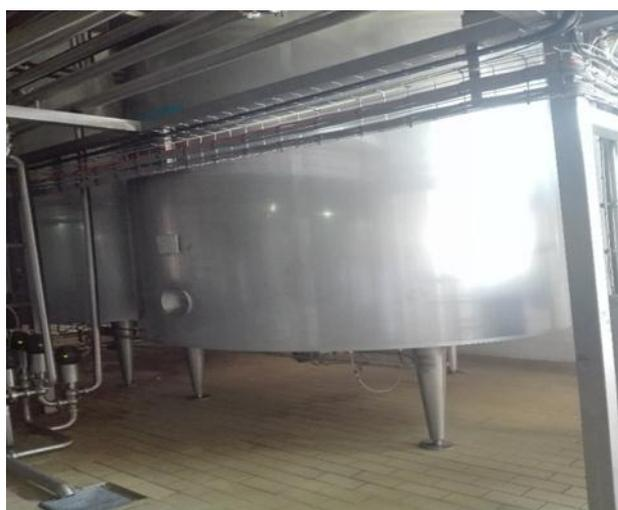
**Figure n°9 : Tanks Lait Pasteurisé (TLP 16000 L) (PHP, 2021).**
