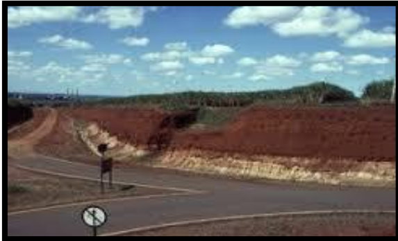
Figure 10. Tranchée de route (Rahmouni et Belhadj, 2014).
