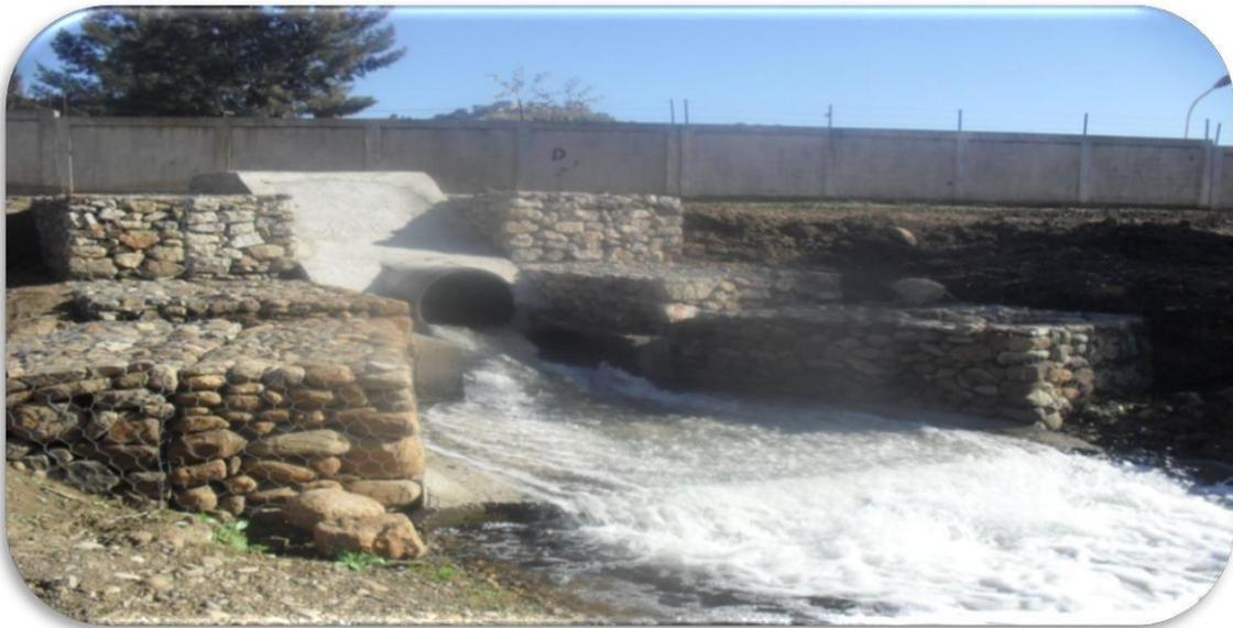
**Figure 10 :** La sortie de l'eau épurée vers l'oued.
