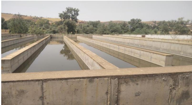
**Figure 09 :** Bassin désinfection de type chicane.
