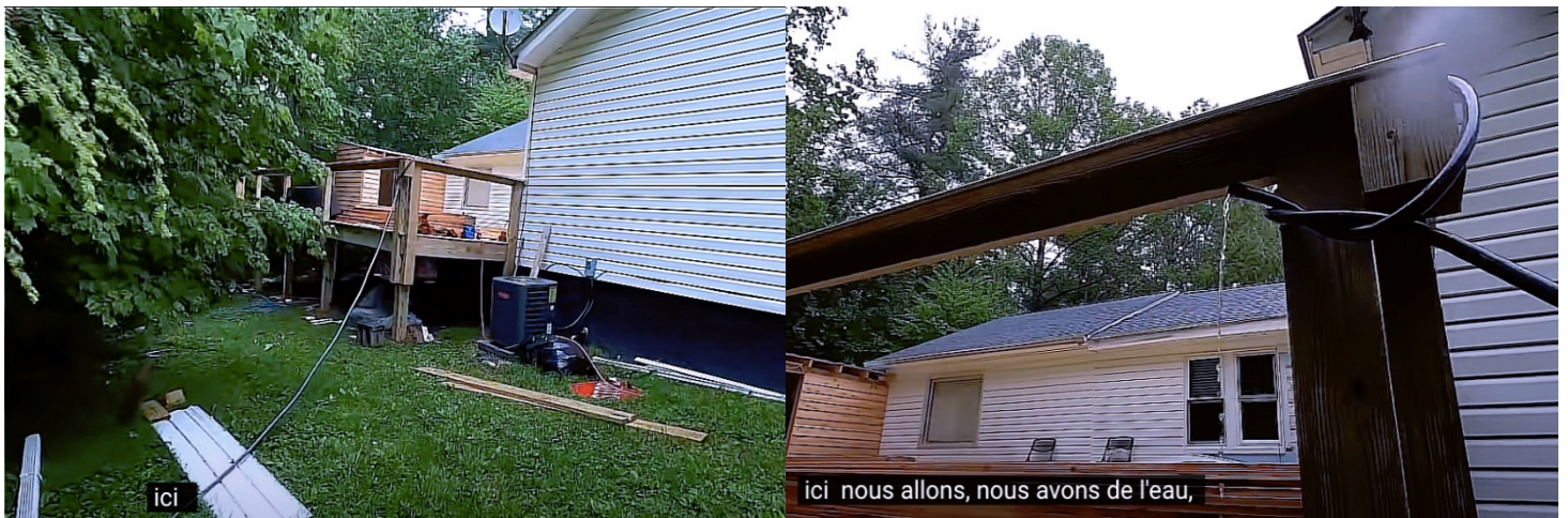
Figure 15 : La conduite de sortie
