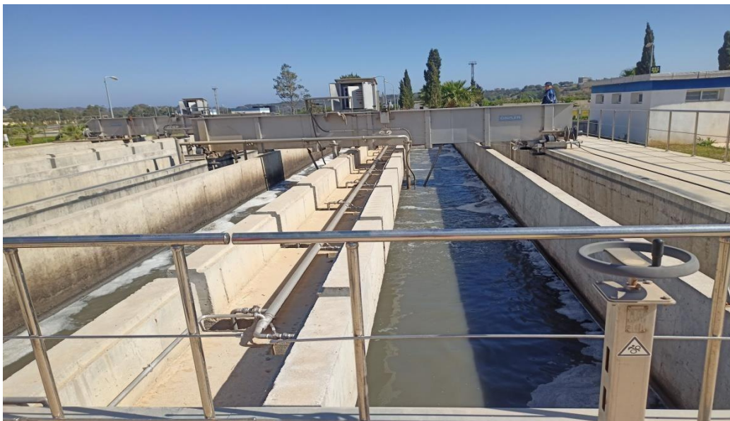
Figure II. 4 : Déssableur dégraisseur.
