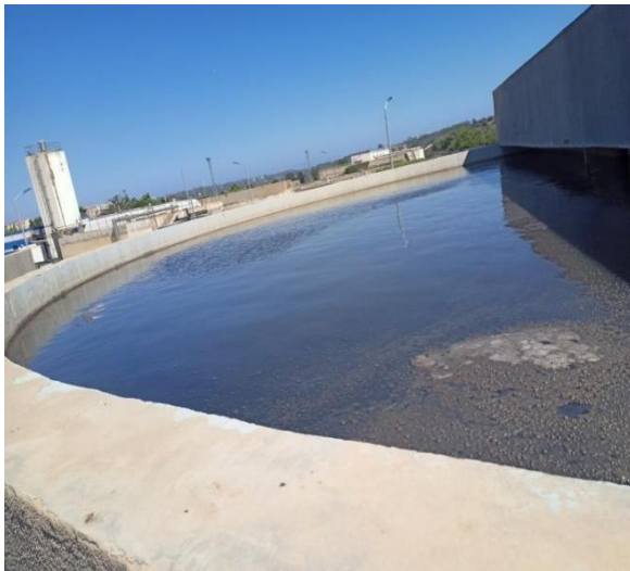
Figure II.9 : Epaississeur pendant le Fonctionnement.
