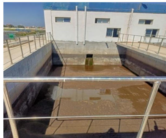
Figure II.8: Filtre à sable vide
