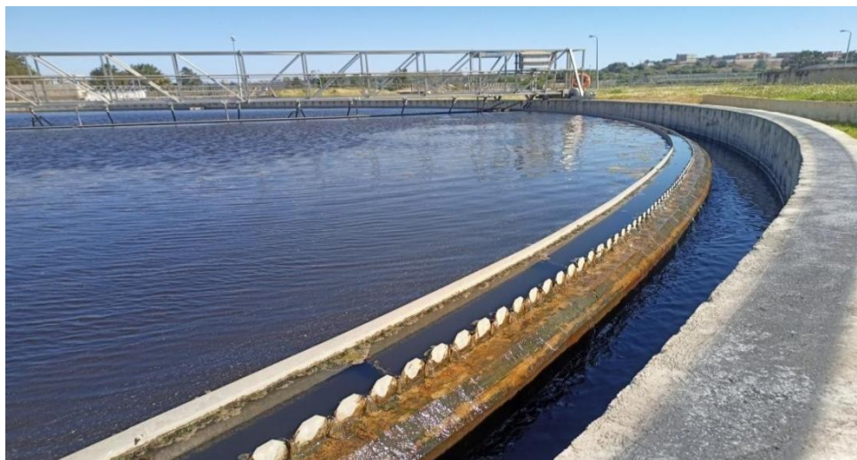
Figure II.6 : Clarificateur pendant le fonctionnement.
