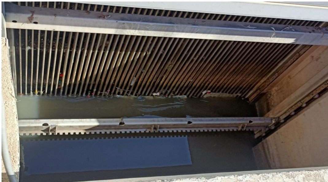
Figure II.3: Dégrilleur grossier.
