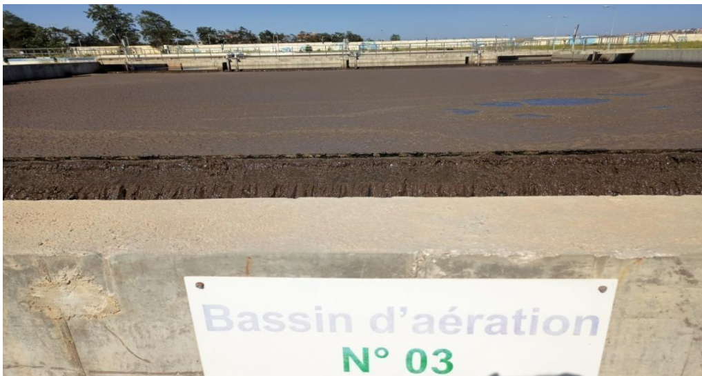
Figure II.5: Bassin d'aération pendant le fonctionnement.
