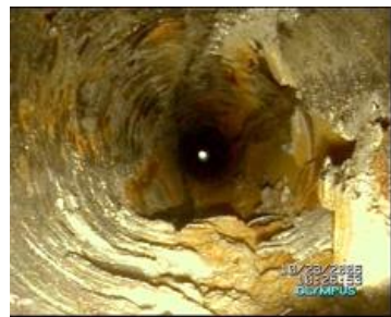
Figure I-17 : dépôts des particules solides sur les tuyaux
