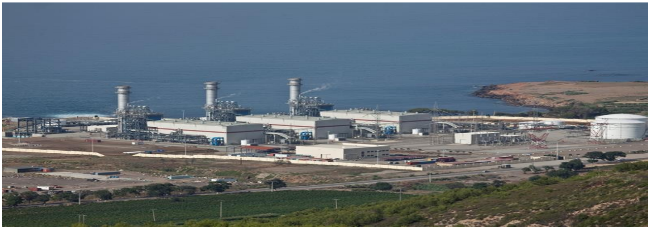
Figure I-2: Vue aérienne de la station SKH [6]
