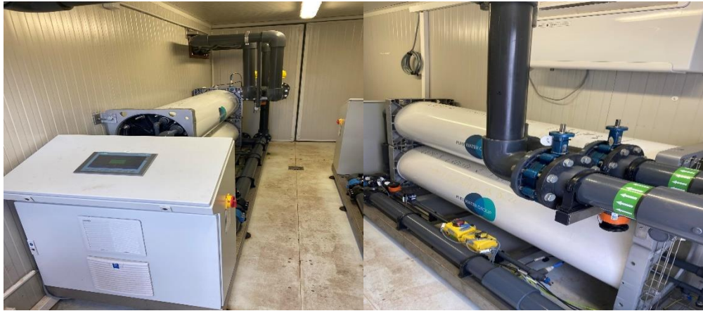
Figure I-15: l'électrodeionisation
